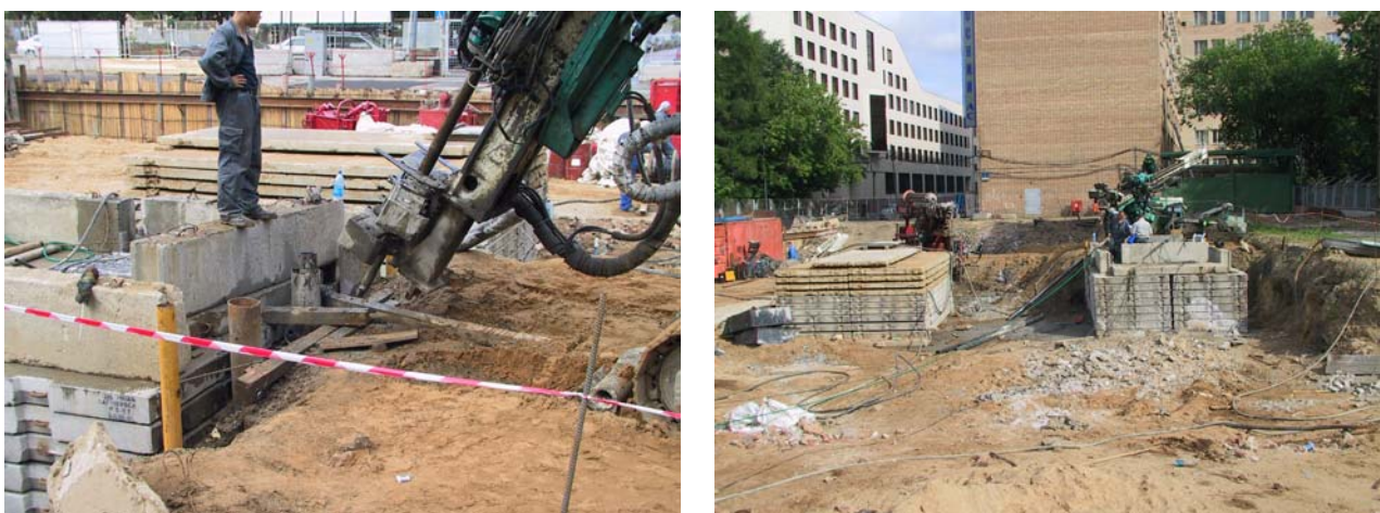
Рис. 10. Работы на опытной площадке по устройству jet-свай
