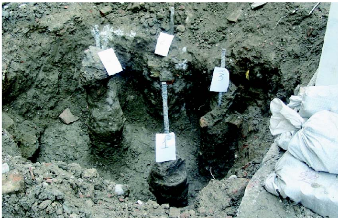
Рис. 9. Опытные сваи, устроенные по технологии «MINIJET» (фотография из проспекта «Minijet»)
