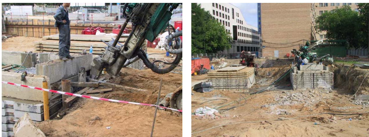
Рис. 10. Работы на опытной площадке по устройству jet-свай
