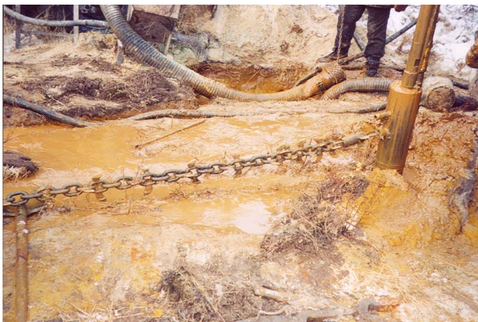
Рис. 13. Цепь установки для прорезания грунта
