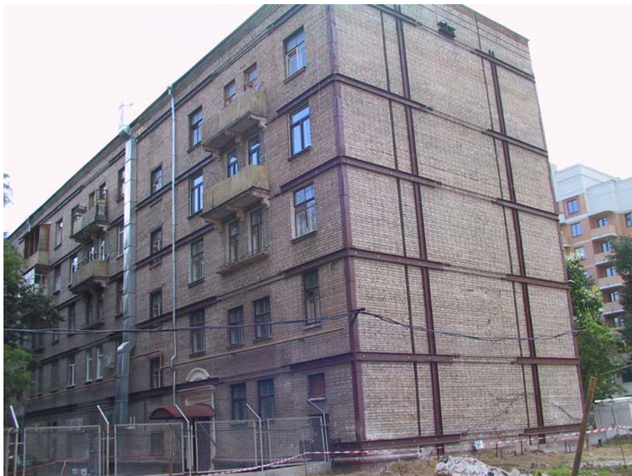
Рис. 7. Метод усиления надземной конструкции здания металлическими тяжами в действии.
