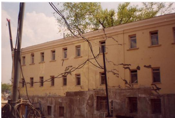
Рис.5 Здание по адресу: ул.Ладужская, 16,находящееся в зоне влияния котлована автодорожного тоннеля на участке 3-го транспортного кольца в Лефортово, после усиления его фундаментов буринъекционными сваями
