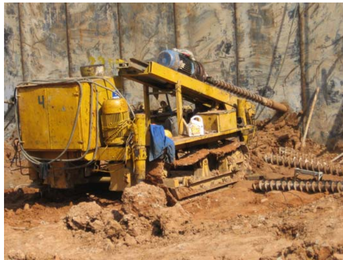
Рис 9. Процесс устройства грунтовых анкеров.
