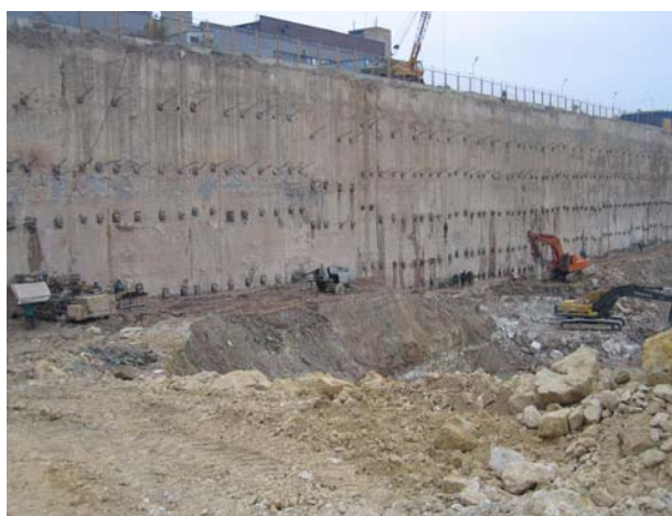
Рис. 3. Ограждение котлована с выполненным анкерным креплением.
