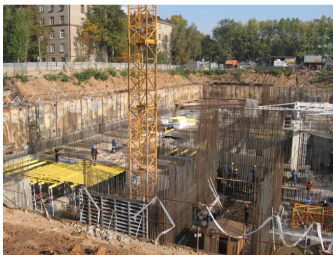
Рис 1. Процесс возведения в котловане подземной части здания.
