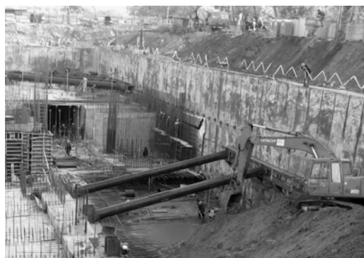
Рис. 6. Замена нижнего яруса анкеров на распорки на участке залегания слабых грунтов.
