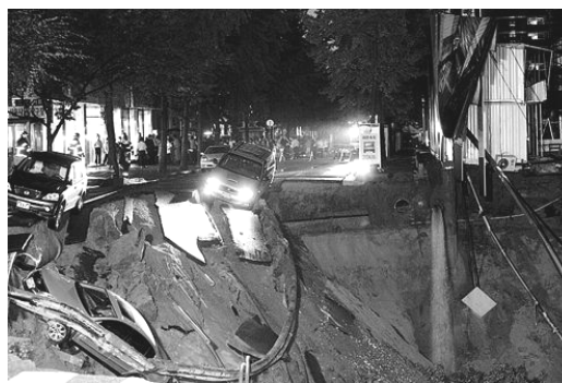
Рис. 54. Обрушение котлована Международного финансового центра в Сеуле (website).
