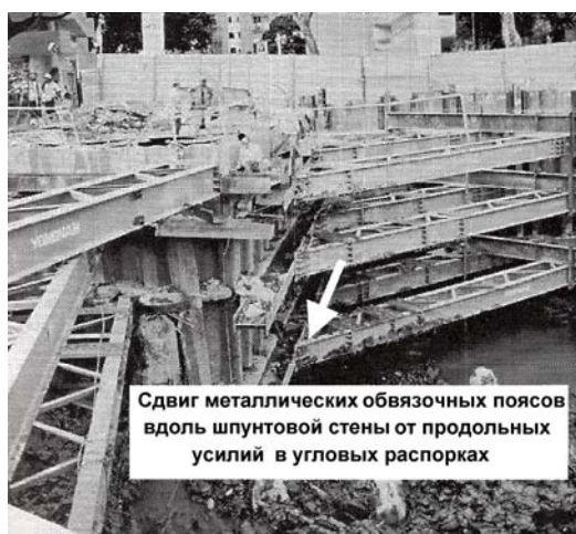
Рис. 15. Сдвиг обвязочных поясов вдоль шпунта более чем на 600 мм (Shirlaw и др., 2005).
