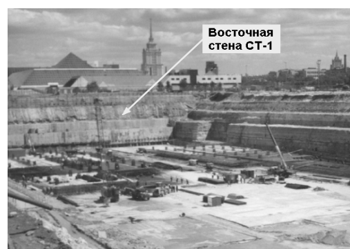
Рис. 25. Восточная стена котлована центрального ядра ММДЦ «Москва-Сити».
