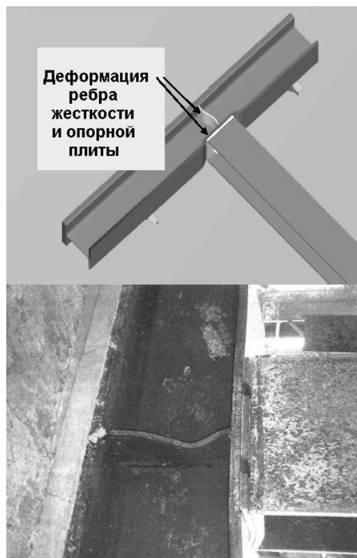
Рис. 23. Выгиб ребра жесткости и опорной части в месте примыкания распорки к обвязочному поясу до случившейся аварии (Nicholson, 2005)
