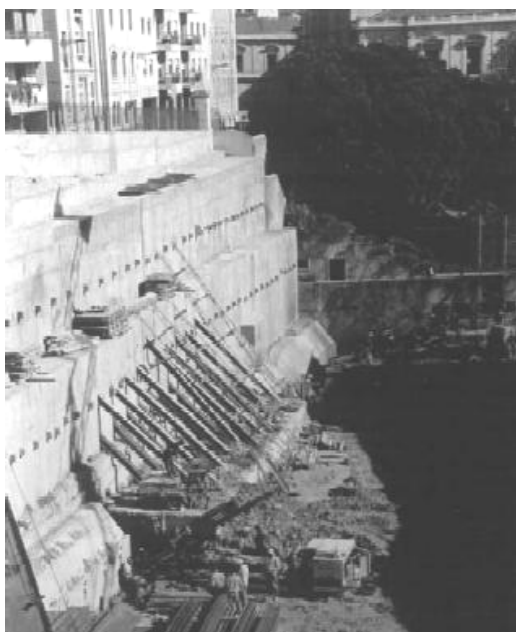
Рис. 8. Противоаварийные мероприятия в котловане при активизации оползня, Лиссабон (Gomes Coelho, 2007).
